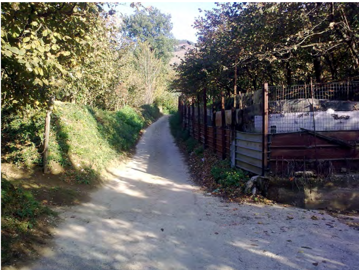
Paletti in ferro da sostituire con pali di castagno
