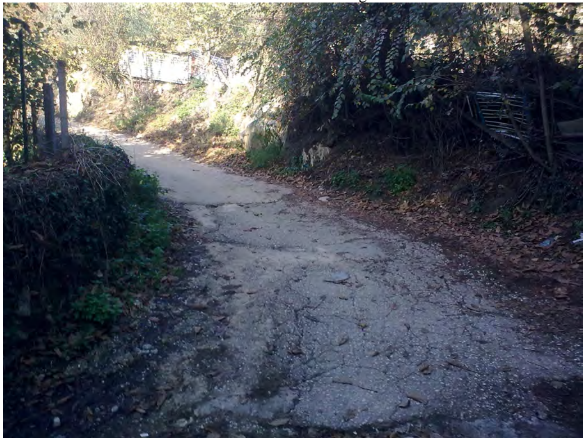
Pavimentazione in conglomerato bituminoso da sostituire con battuto pigmentato
